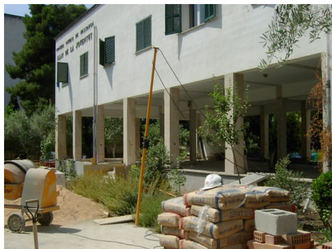
Construcció de la nova seu de la FELIB.
